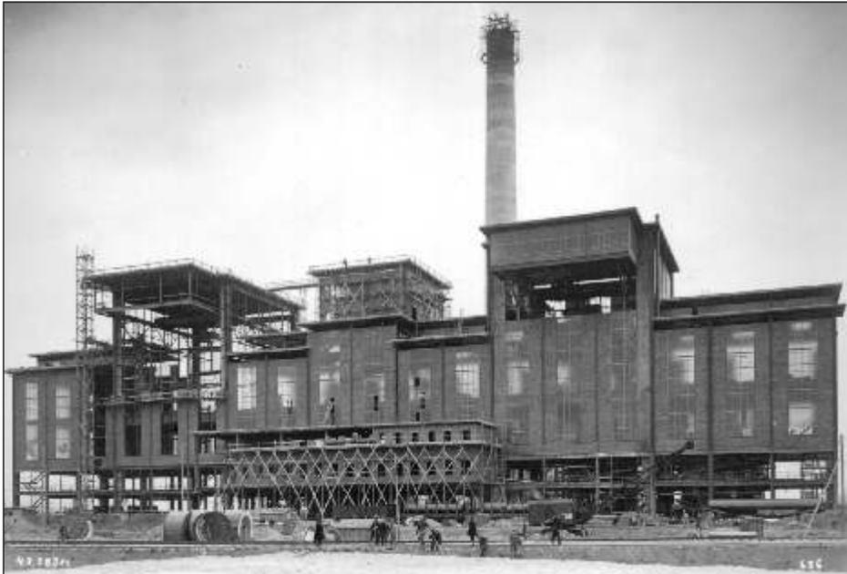
Bild 8 Die Calciumcarbidfabrik I 21 im Aufbau
