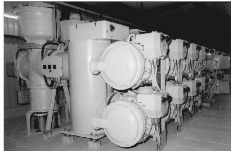
Bild 40 Neue 110 kV-Schaltanlage (SF6) M 17
