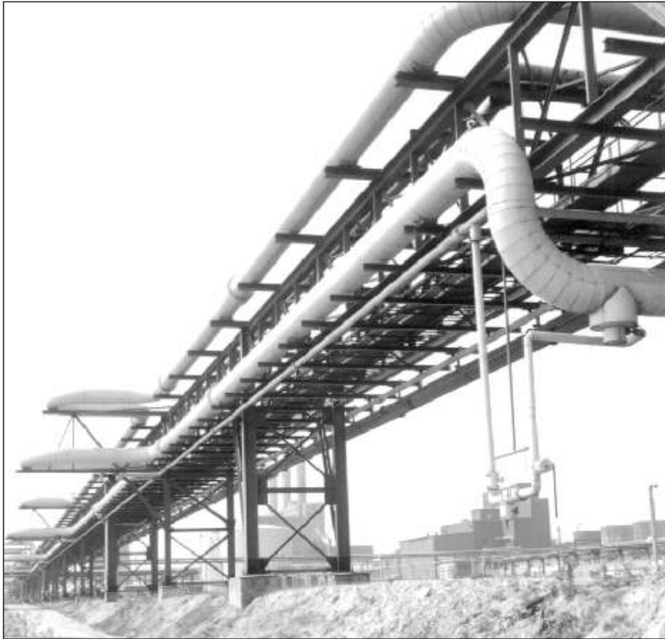
Bild 26 Energieleitungen auf Rohrbrücken
