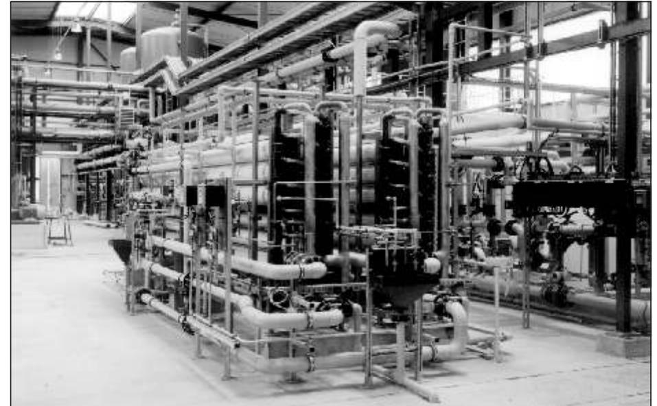
Bild 39 Neue Deionat-Erzeugungsanlage E 107
