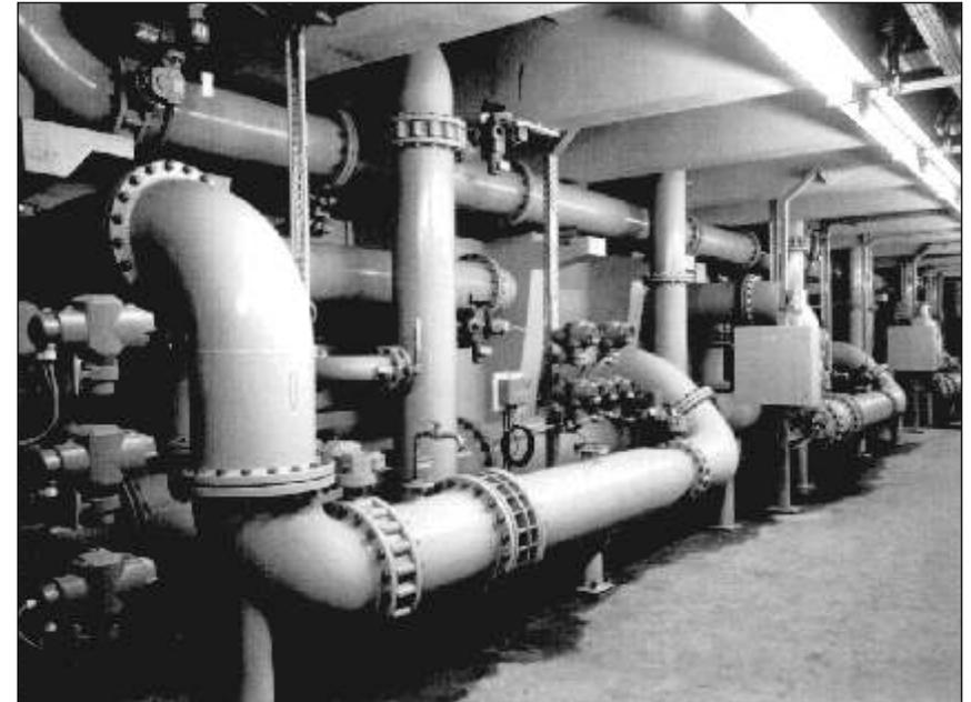
Bild 37 Rekonstruierter Rohrkeller im Filterbau des Wasserwerkes
