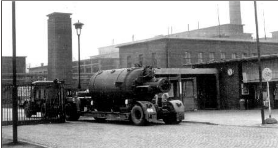
Bild 7 Emaillierte Polymerisationskessel aus Thale für D 89
