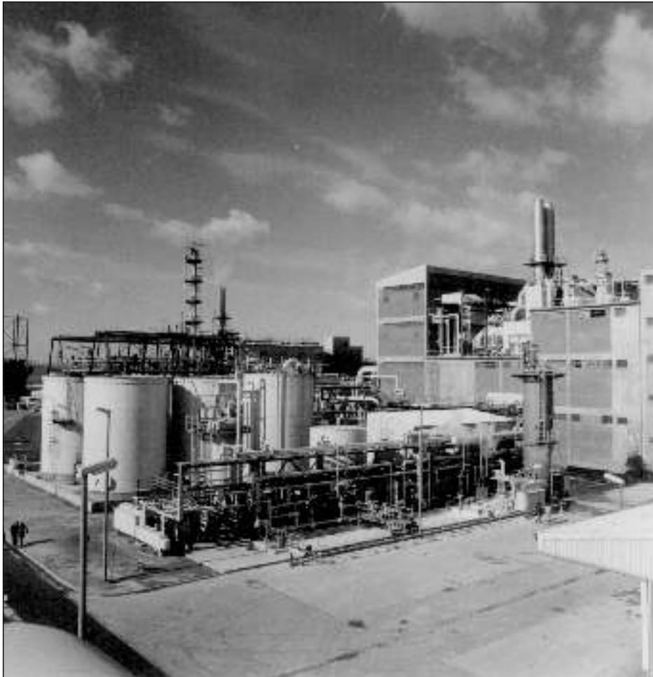
Bild 15 PVC-E-Anlage mit Emulsionstanklager und Abwasseraufbereitung im Vordergrund
