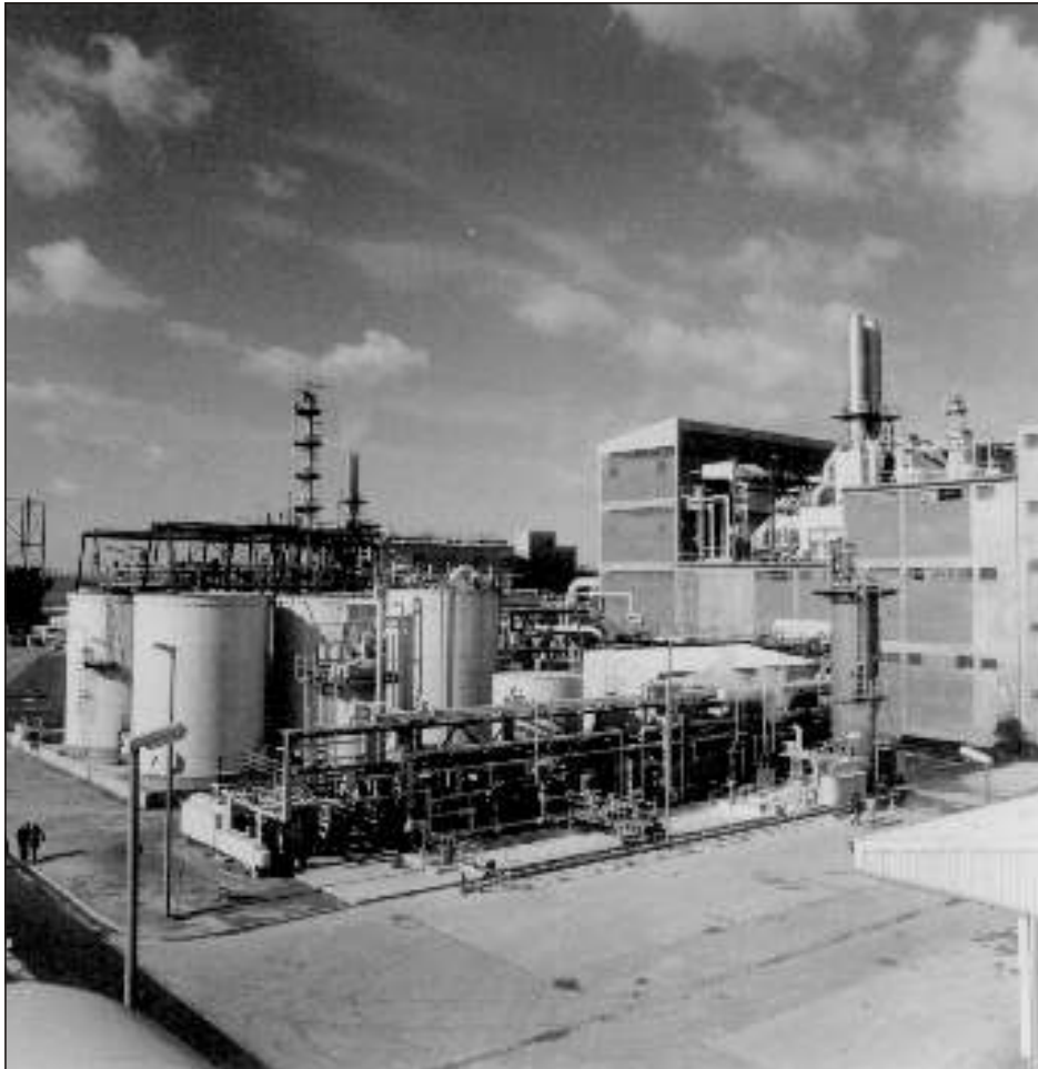
Bild 15 PVC-E-Anlage mit Emulsionstanklager und Abwasseraufbereitung im Vordergrund
