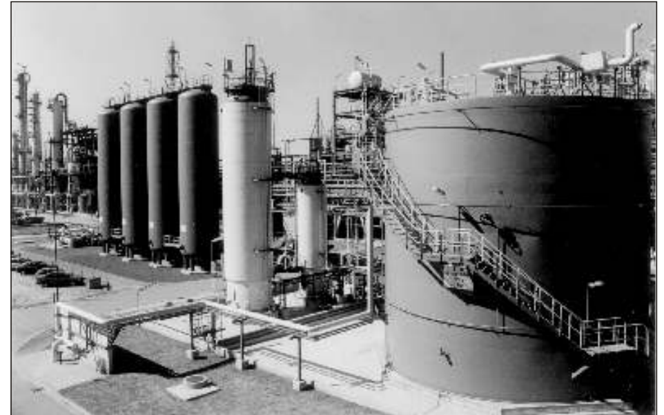
Bild 5 Blick auf die Oxychlorierungsanlage von Westen
