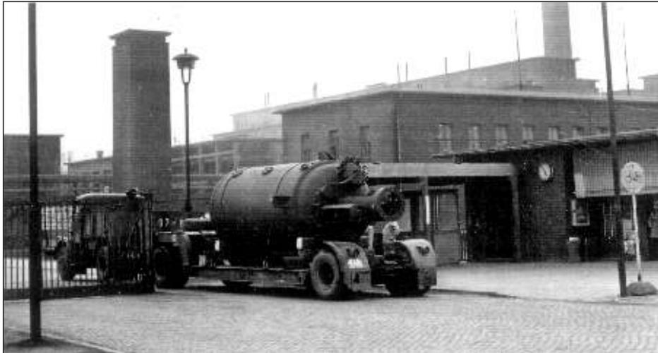
Bild 7 Emaillierte Polymerisationskessel aus Thale für D 89
