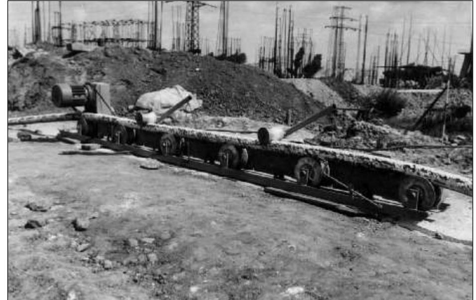
Bild 15 Kabelverlegungsmaschine
