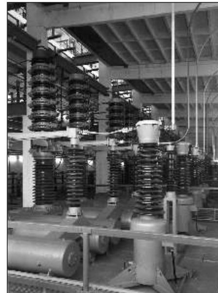
Bild 7 110 kV Innenraum-Schaltanlage
