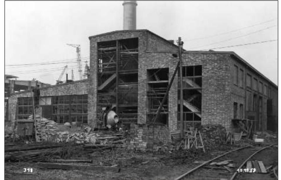
Bild 6 Bau der 110 kV Innenraum-Schaltanlage
