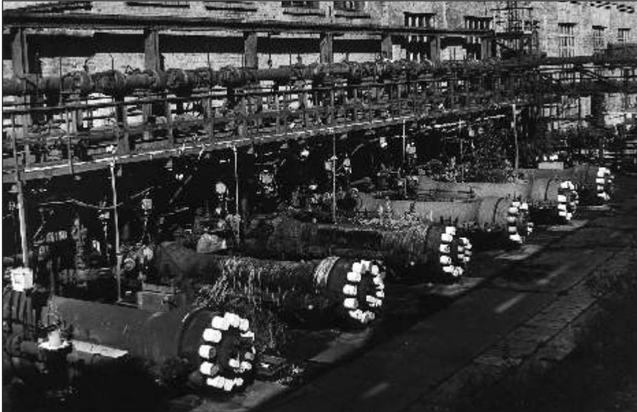
Bild 1 Maulwurfpumpen im Einsatz in den Leuna-Werken
