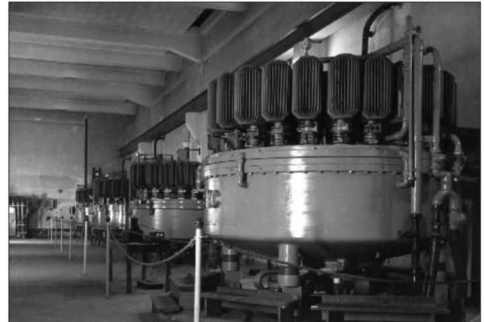
Bild 23 Quecksilberdampf-Großgleichrichter in der Elektrolyse des Buna-Werkes Schkopau
