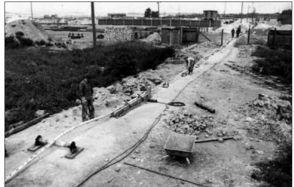
Bild 16 Maschinelle Kabelverlegung
