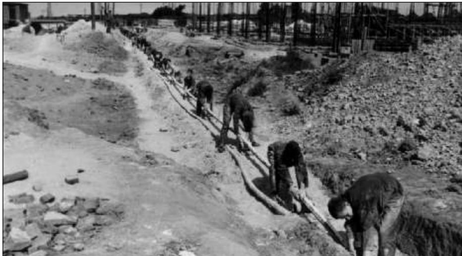
Bild 14 Manuelle Kabelverlegung
