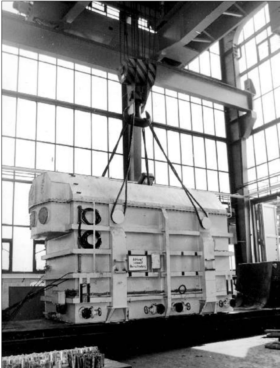
Bild 22 Ein Ofentransformator wird mit einem Spezialfahrzeug der Reichsbahn in die Transformatorenwerkstatt A 89 des Buna-Werkes Schkopau gebracht
