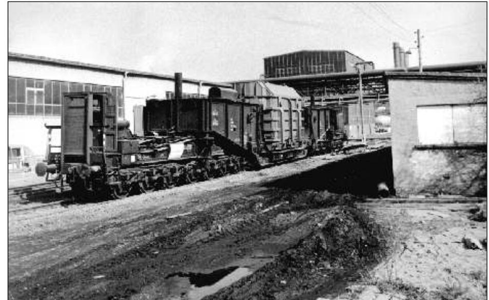
Bild 4 Anlieferung eines Reparaturtransformators nach A 89 per Schiene
