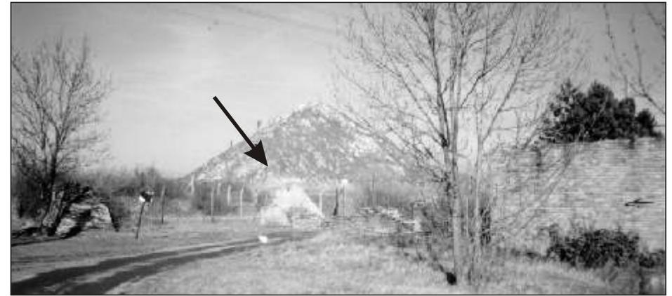
Bild 19 Die heutige Ansicht des ehemaligen Schachtes Johannashall. Rechts, das Mauerwerk, war das Maschinenhaus für die Fördermaschine. Vor der Halde sind die Stützfundamente des Schachtgerüsts zu sehen (Pfeil)
