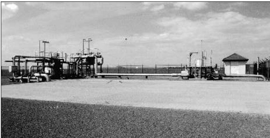
Bild 62 Anlagen am Sondenkopf der Ethylen-Speicherkaverne
