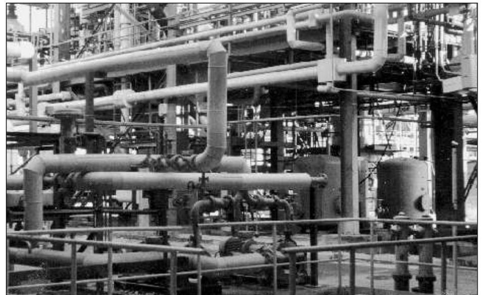
Bild 33 Produkt- und Energieleitungen in neuer Chlorkautschuk-Anlage
