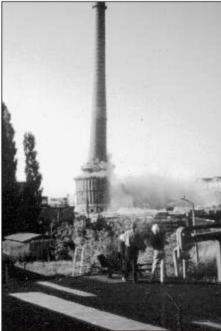
Bild 26 Sprengung des 100-m-Schornsteines am 01.07.1995, erste Phase
