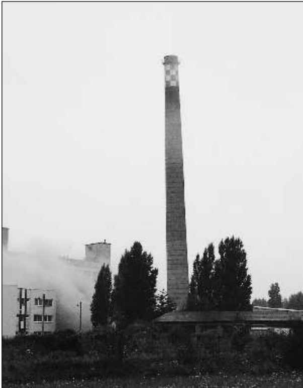
Bild 52 Sprengung der beiden 100 m-Schornsteine des Heizöl-Kraftwerkes am 22. Juli 2000
