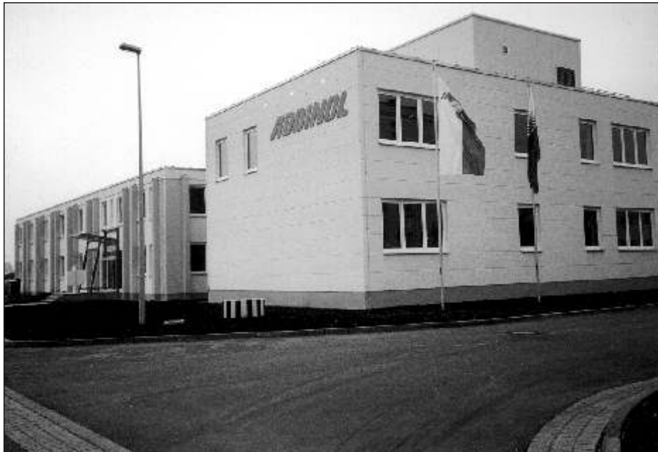
Bild 54 Neues Betriebsgebäude am Standort Leuna
