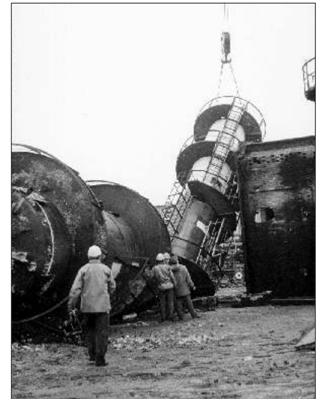
Bild 51 Demontage der Kolonnen der Destillation Ost (Bau 302)
