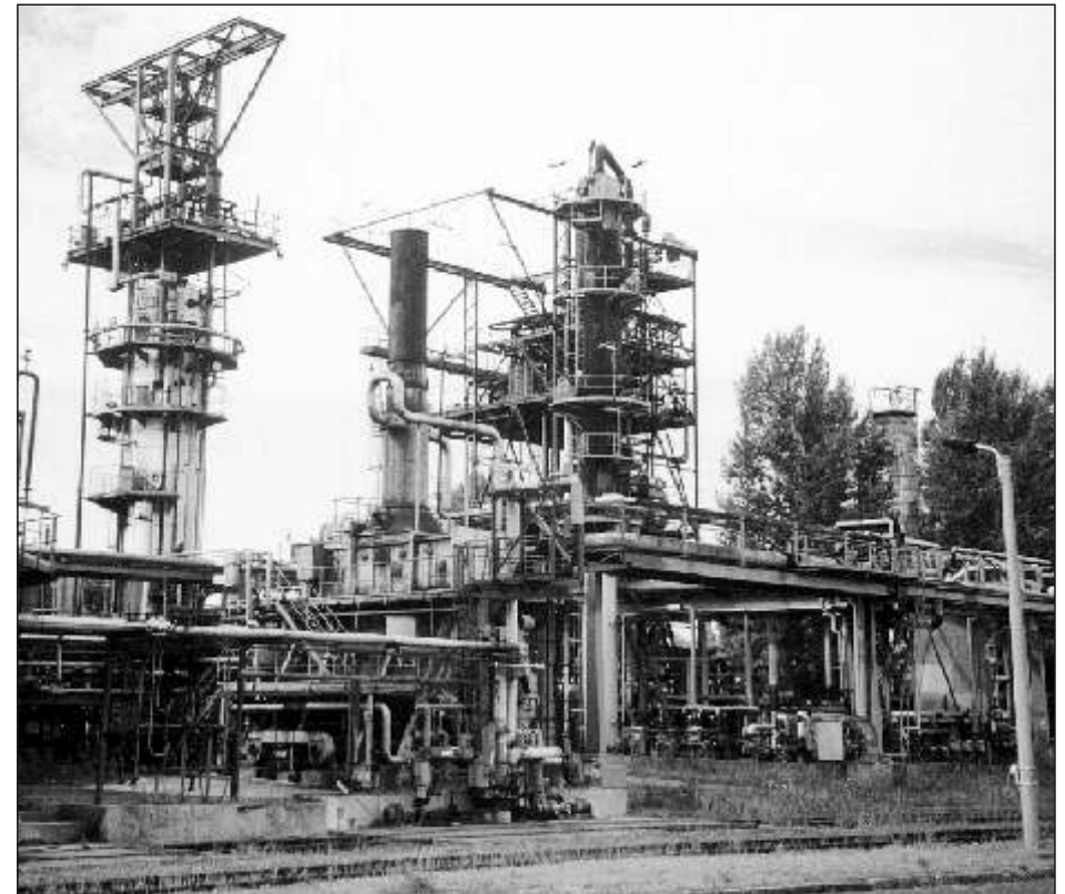
Bild 42 Kolonnengerüst und Ofen der Altöl-anlage (links die Vakuumkolonne der Kontaktbleichung)
