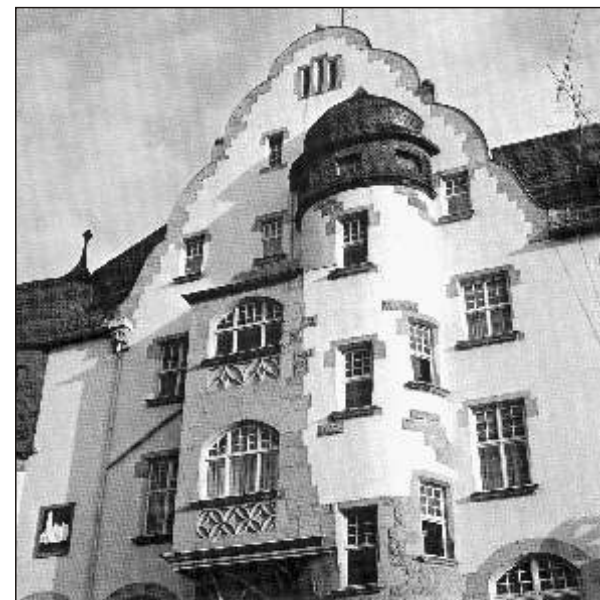
Bild 21 Fassadenanstrich auf Basis von Scopacryl D 343
