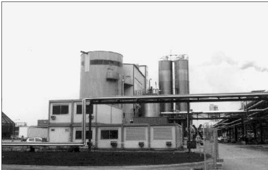
Bild 25 Die neue Produktionsanlage für Dispersionspulver (1996)
