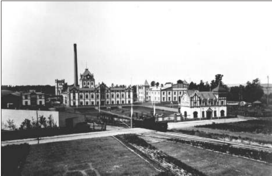
Bild 13 Das Territorium des späteren Reifenwerkes, etwa um 1910, rechts Heico, links Hafen- und Hobewerk, Blick aus östlicher Richtung
