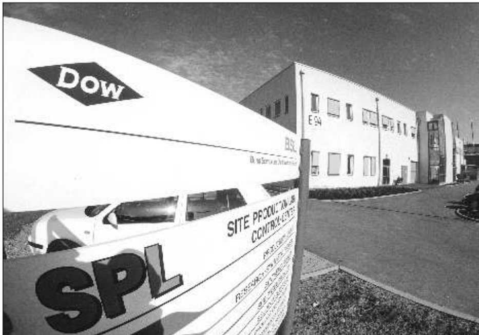
Bild 5 Blick auf das neue Meßwartengebäude E 94
