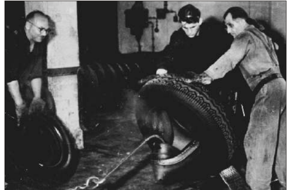
Bild 57 Heizschlauchziehen 1960, ein Arbeitsgang mit großen Qualitätsauswirkungen
