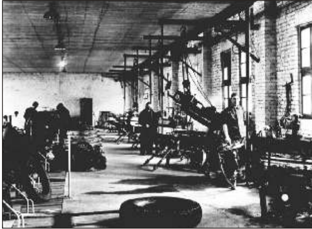
Bild 8 Heizraum in der Chemnitzer Hohle, 1947
