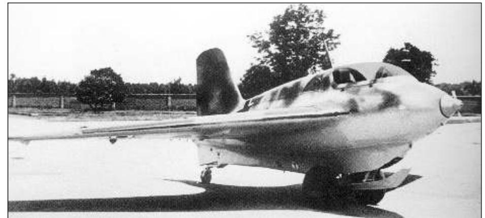
Bild 1 Me 163 B "Komet" in Startposition mit Rollwagen" an der Kufe
