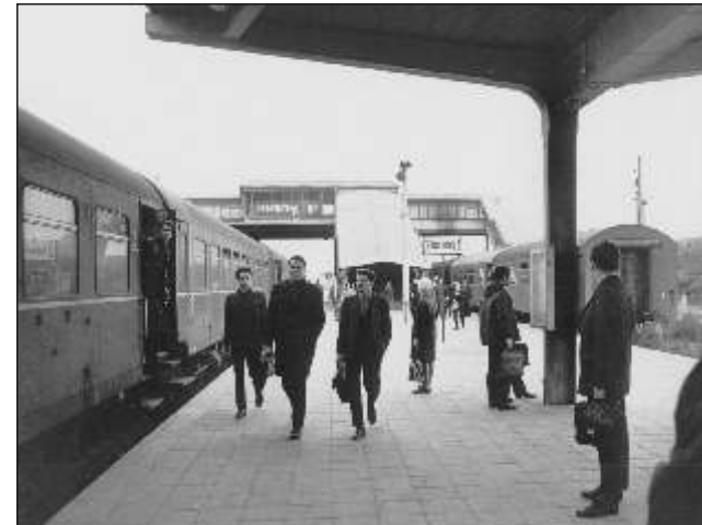
Bild 44 Bahnsteig des neuen Personenbahnhofs mit Zu- und Abgang über die Fußgängerbrücke F 122
