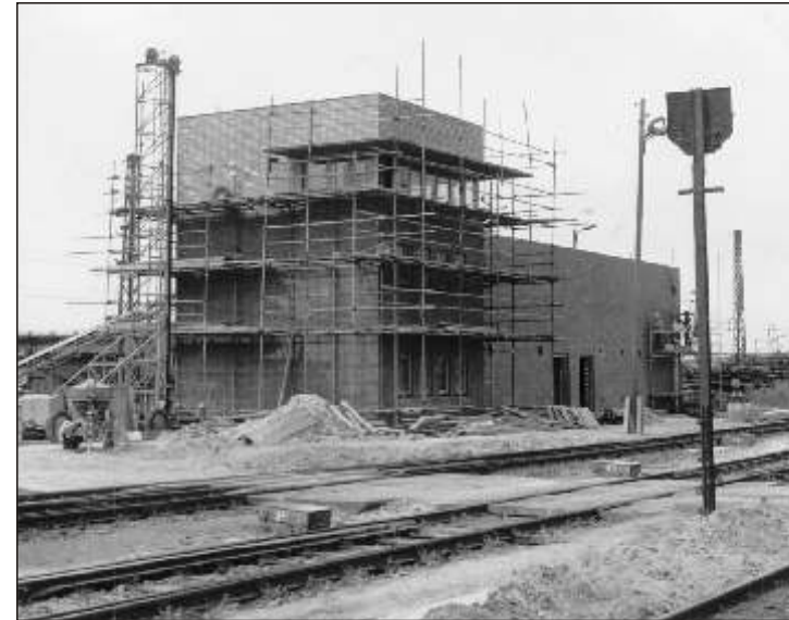
Bild 36 Rohbau des neuen Spurplanstellwerks L 143
