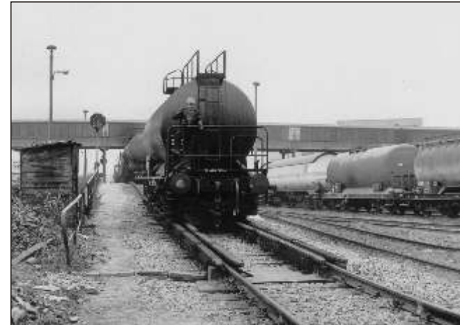
Bild 28 Ablaufberg des Werkbahnhofs unterhalb der Fußgängerbrücke F 122, hier schon mit der später eingebauten elektromechanischen Bergbremse
