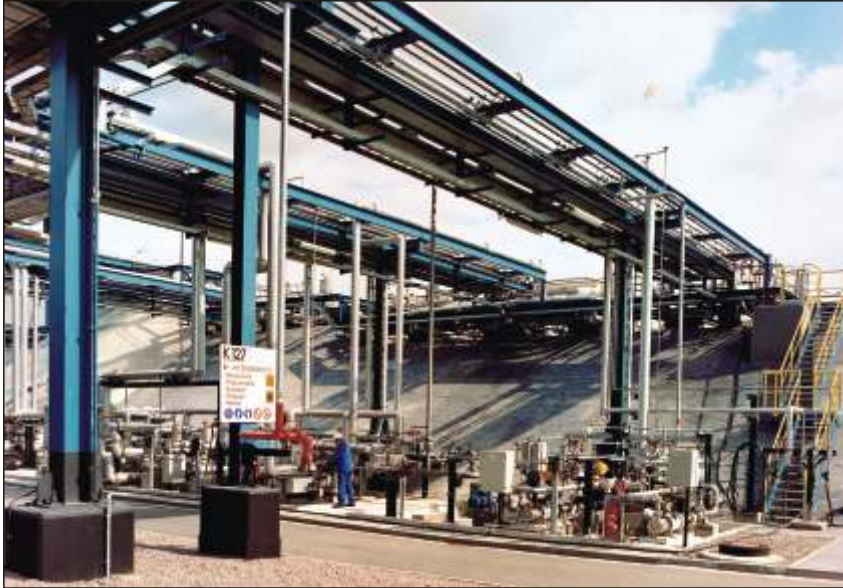
Bild 57 Be- und Entladeanlage für Kesselwagen in Schkopau
