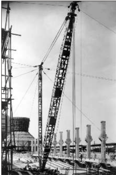
Bild 60 Derrick-Kran im Einsatz
