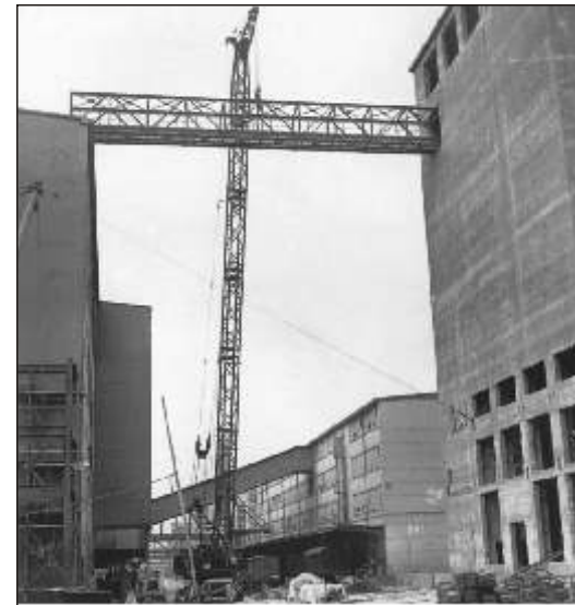
Bild 62 50-t-Mobilkran bei der Montage der Förderbrücke von D 89 nach D 82 a
