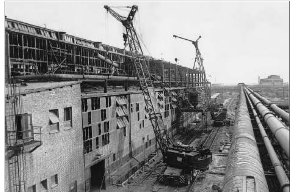
Bild 61 50-t-Mobilkran bei Arbeiten an der VC-Fabrik I 97
