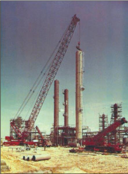
Bild 14 Aufbau der Destillationskolonne DT-31 in der Bauphase 1972
