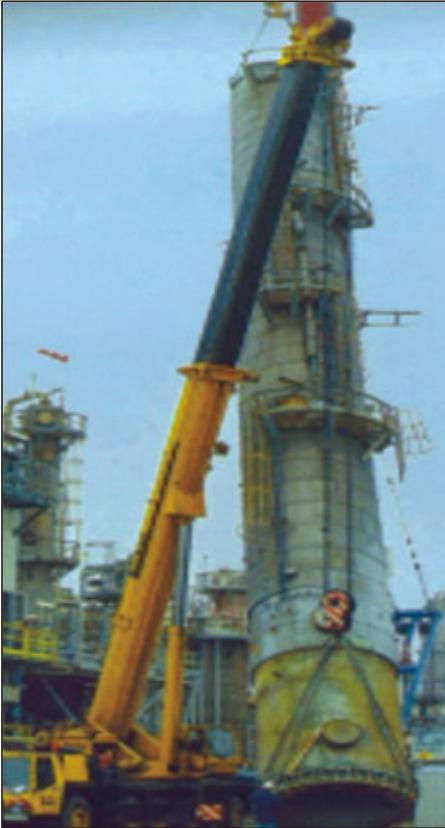
Bild 29 Der Teleskopkran hievt die Kolonne HAT-310 aus der Produktionsanlage
