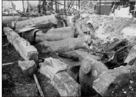
Bild 10 Blick auf die zerstörten EO-Tanks
