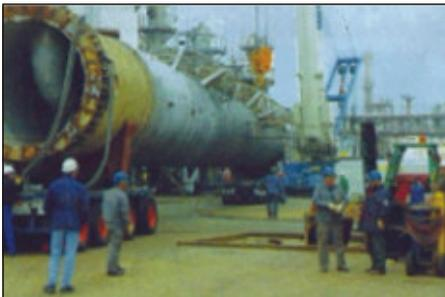
Bild 30 Umzug der Destillationskolonne
