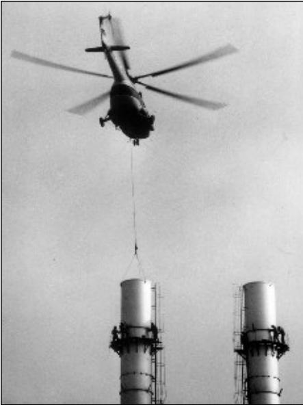
Bild 2<sup>o</sup>) Montagearbeiten mit Hubschrauber an den Blechschloten in ca. 50 m Höhe
