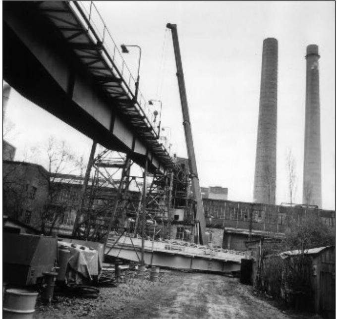
Bild 4 Demontage der alten Bandbrücke aus dem Jahr 1936 und Montage der neuen Bandbrücke im Jahr 1986
