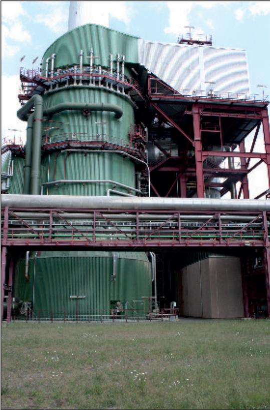
Bild 17 Ein Absorberturm der Rauchgasentschwefelungsanlage (REA)
