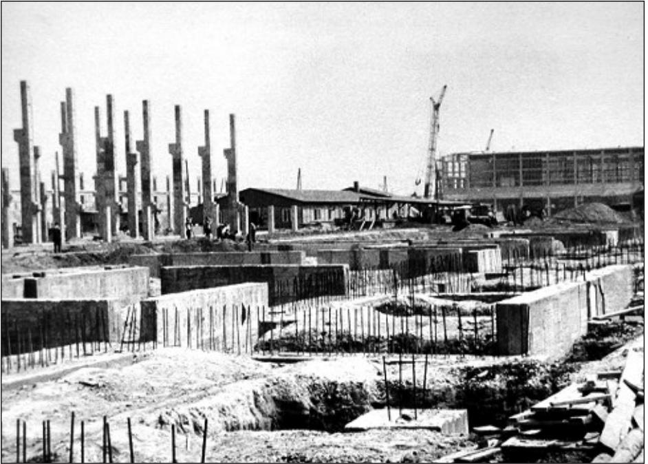
Bild 5 Errichtung der Fundamente für die ICI-Straßen 1-3 im Jahr 1963
