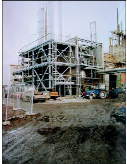
Bild 11 Die Stahlkonstruktionen für Hauptextruder und Niederdruckseparator sind fertig
