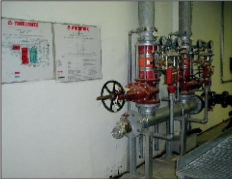
Bild 27 Kontrollausrüstungen für das Sprinklersystem in der Reaktorkammer Train 4 (Dezember 1998)
