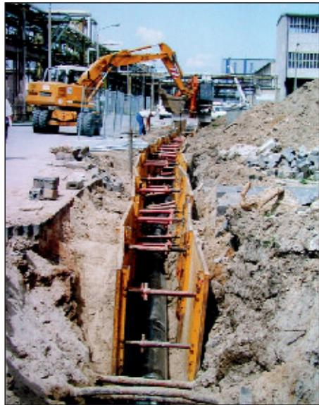
Bild 26 Verlegen der ersten Sektion der 12 bar-Feuerwasserlöschleitung am Train 4 (Juni 1998)
