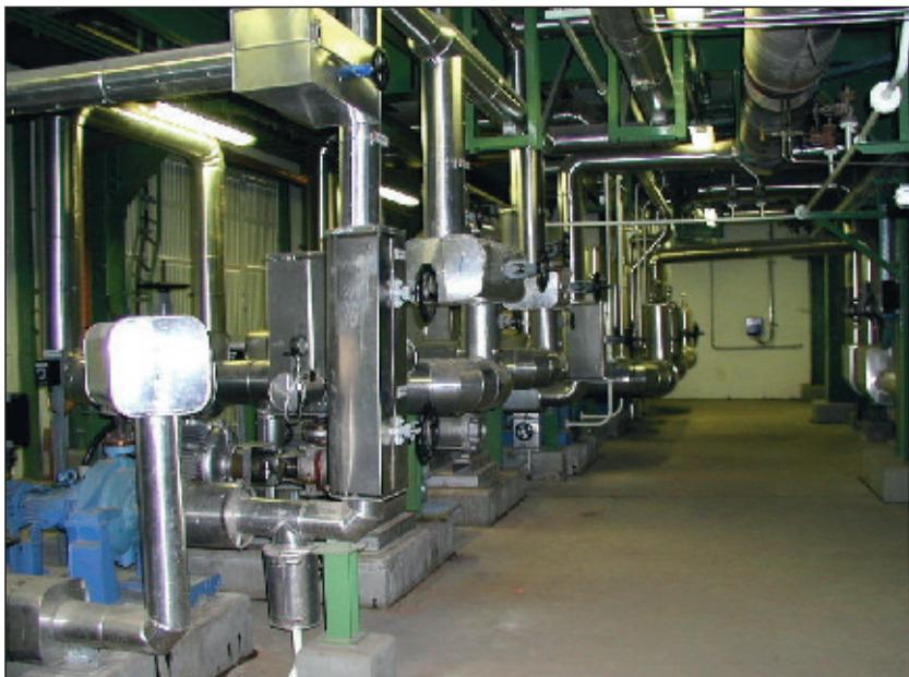
Bild 9 Die neue Heißwasserstation für Train 4 nach der Rekonstruktion (Dezember 1998)
