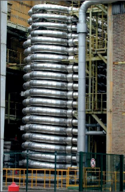
Bild 5 Reaktor Train 5 nach der "Autofrettage" (Oktober 1998, vgl. Bild 20 im Beitrag R. NITZSCHE)
