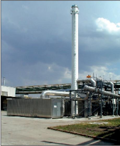
Bild 24 Katalytische Abgasverbrennungsanlage für die Lager- und Siloeinheit Train 5 (Dezember 1997)
