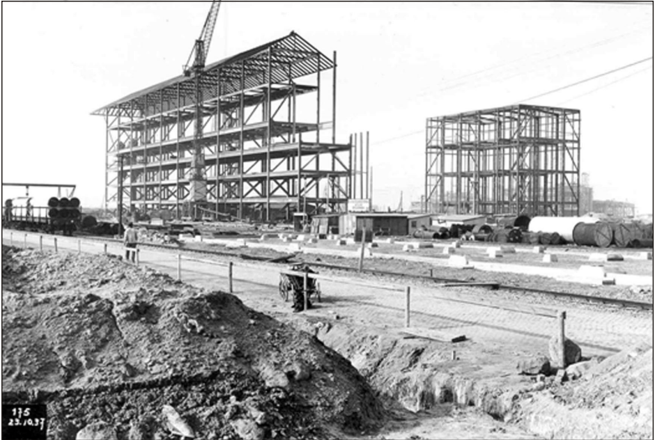
Bild 19 Acetaldehyd-Destillation F 34 mit dem Metallspitzdach (links) und die Acetaldehyd-Generation F 44 noch ohne Spitzdach (rechts) im Oktober 1937
