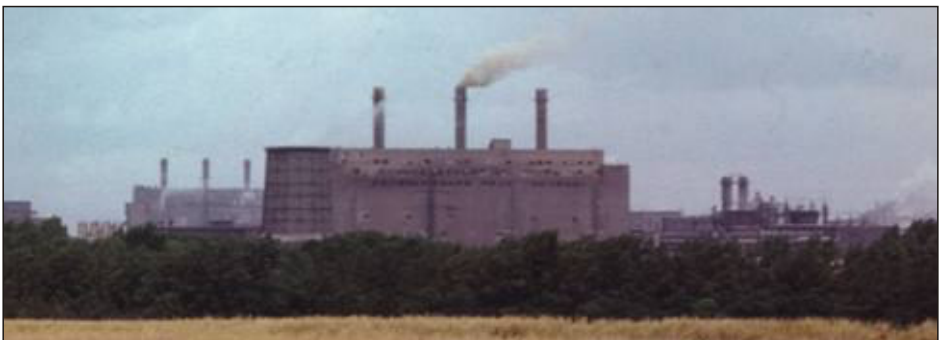
Bild 3 EGR-Ausfall im Kraftwerk A 65, um 1985
