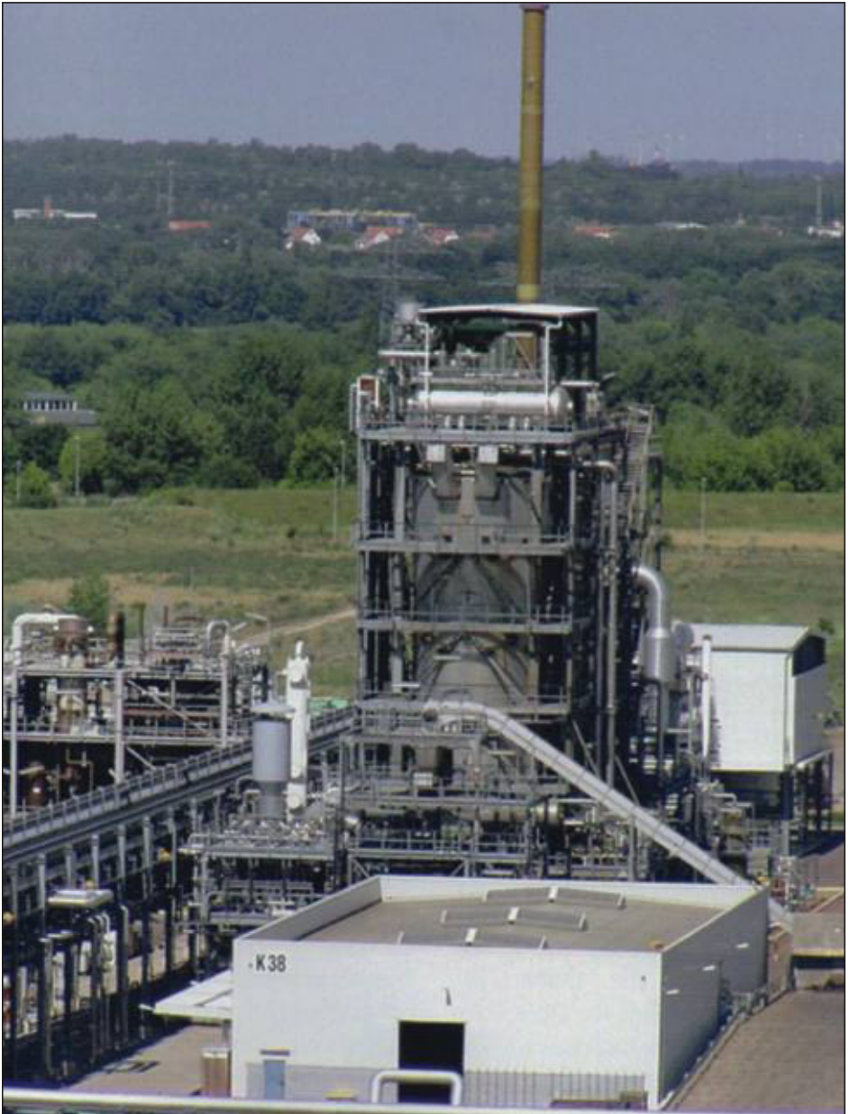
Bild 19 Abfallverwertungsanlage am Standort Schkopau [22s]
