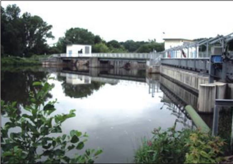
Bild 14 Blick auf die Einläufe von Wehr und Kraftwerk in Planena
