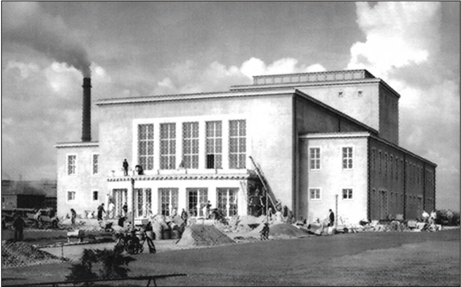
Bild 20 Das Buna-Klubhaus "Freundschaft" kurz vor seiner Fertigstellung im Oktober 1953 (im Hintergrund das Werksgelände und der Carbid-schornstein) [10b]
