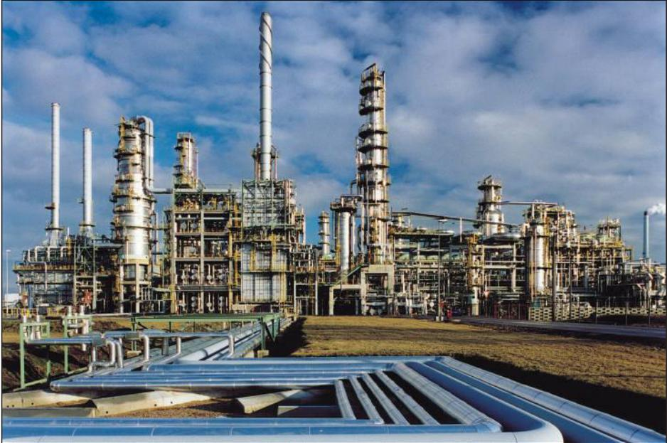
Bild 1 Blick auf den vorderen Teil der Total Raffinerie Leuna-Spergau mit Vakuumdestillation und atmosphärischer Destillation (links) und Visbreaker (Mitte)
