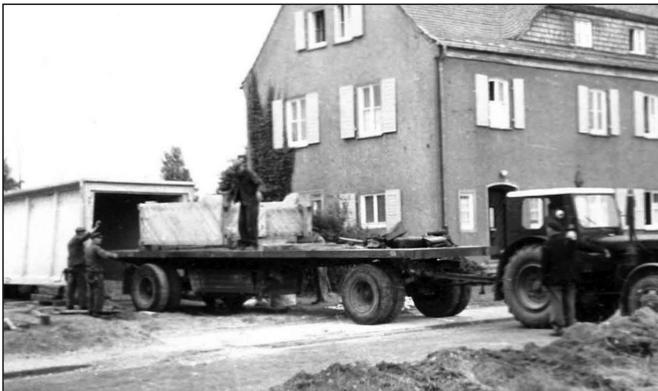
Bild 3 Die Garage ist auf dem Fundament abgesetzt
