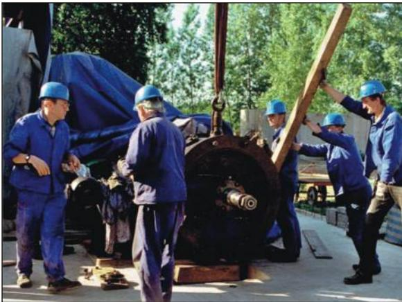
Bild 17 Montage Dampfzylinder (1998)
