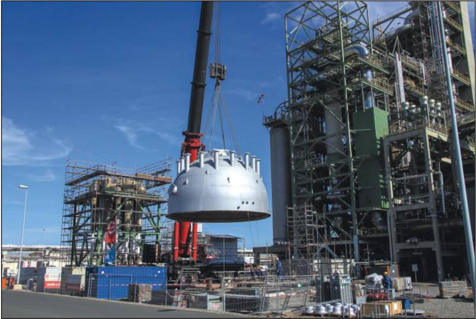
Bild 8 Reaktorkuppel am Haken (Generalinspektion 2014)
