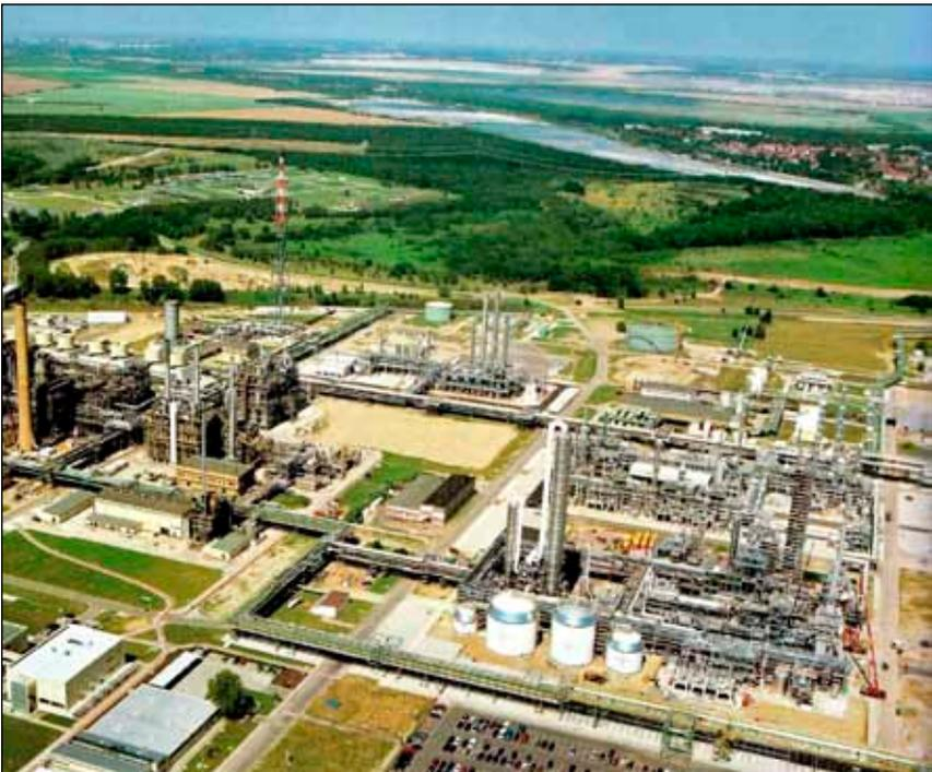
Bild 9 Blick von Süden auf den zentralen Teil des Standortes Böhlen (oben am linken Bildrand der Cracker, rechts daneben das freigehaltene Baufeld für einen zweiten Cracker, unten am linken Bildrand das zentrale Böhleener Control Center, rechts im Bild die Ethylbenzol-Styrol-Anlage, vgl. Bild 2) [3c]
