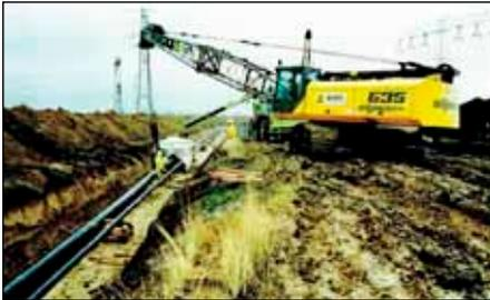
Bild 25 Pipelineverlegung (1996/97) [15c]
