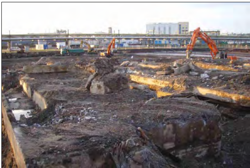
Bild 12 Baufeldvorbereitung B 67 für die Epichlorhydrinherstellung
