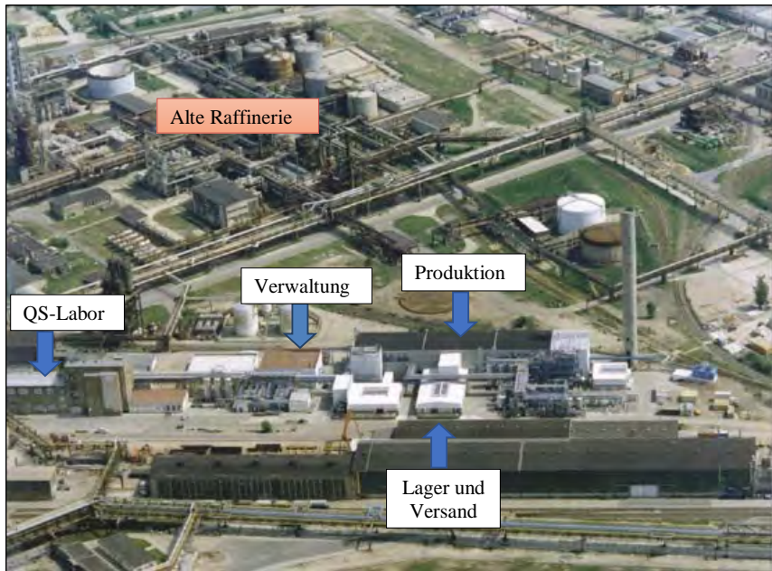
Bild 7 Blick auf die Anlagen der LEUNA Harze GmbH im Jahre 1997 (vgl. Bild 7 auf Seite 14)
