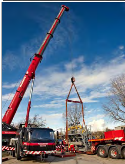
Bilder 2a+b Blick von Südwesten (oben) auf die Logistik von Transport und Hub der Vakuumanlage mittels Mammoet-Autokran auf das Gelände des DChM-Technikparks (Aufnahmen: 3.11.2021)
