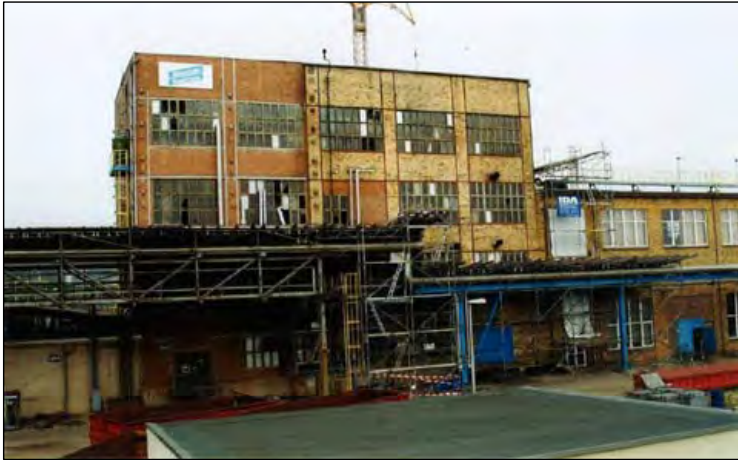
Bild 10 Alte LEUMAL- Anlage (2007)
