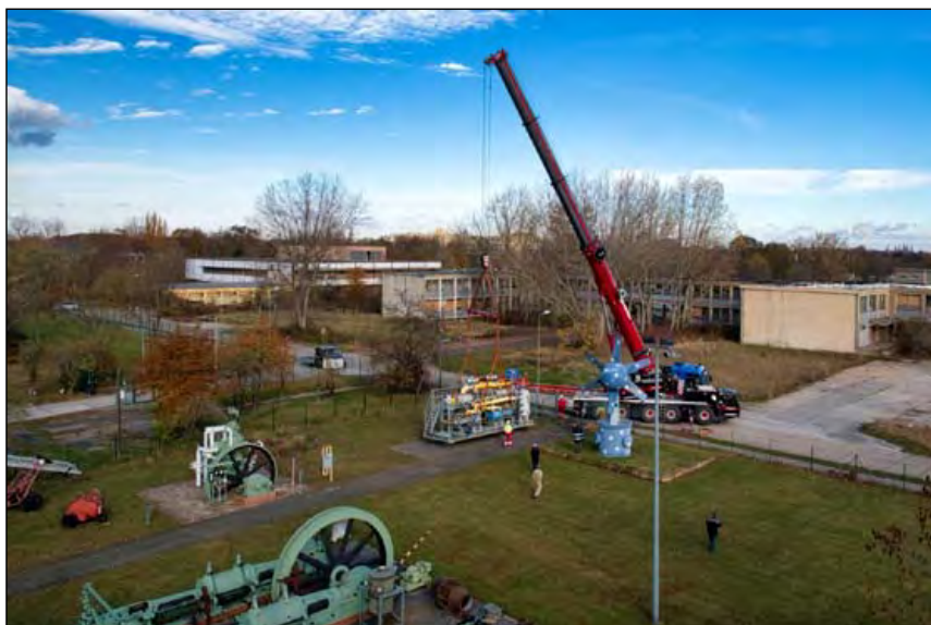
Bilder 2a+b Blick von Südwesten (oben) auf die Logistik von Transport und Hub der Vakuumanlage mittels Mammoet-Autokran auf das Gelände des DChM-Technikparks (Aufnahmen: 3.11.2021)
