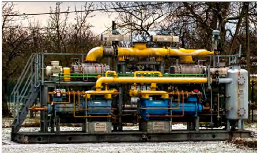
Bild 1 Die Vakuumanlage von DOMO Chemicals Leuna im DChM Merseburg (Blick auf die Vorderseite mit den vier Vakuumpumpen, Aufnahme: 4.12.2021)
