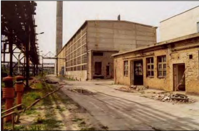
Bilder 6 a+b Bau O 72 Vorderansicht (oben) und Rückansicht (unten, Aufn.: beide 1995)
