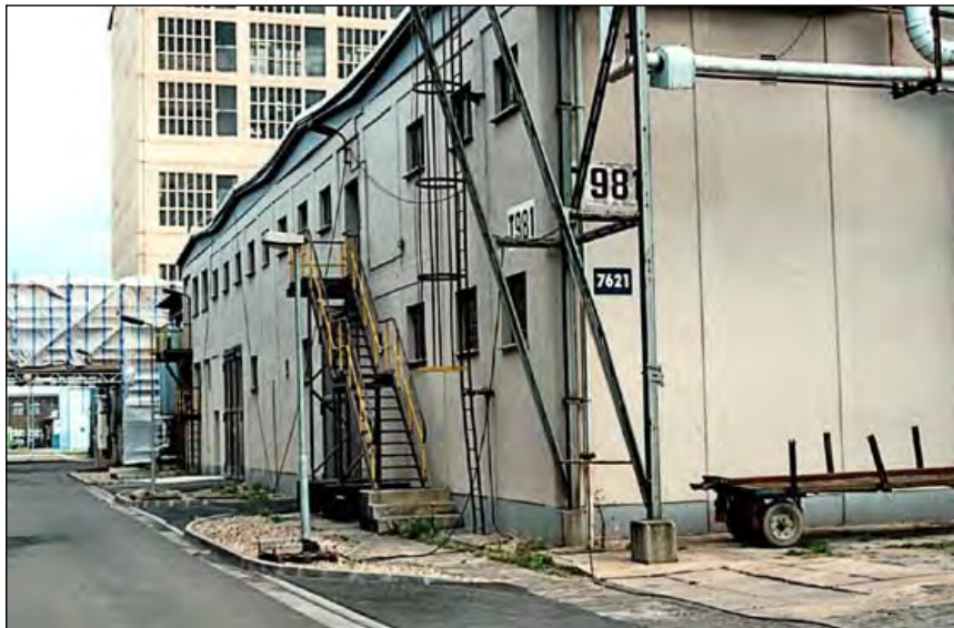
Bilder 4a+b Blick auf die ehemalige Lackfabrik Bau 981 (Bild oben: Luftbild des Areals an der Spargauer Straße, Aufnahme: Juni 2010, Bild unten: Blick auf die ehemalige Lackfabrik T 981, neu 7621, Aufnahme: 27.10.2000)
