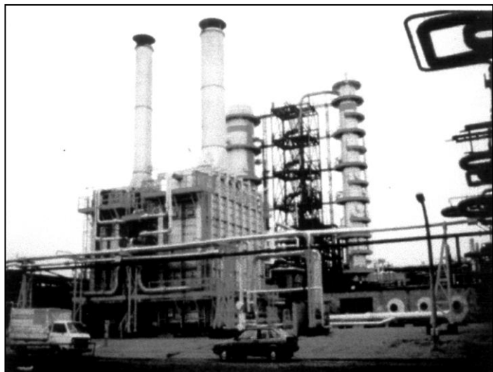
Bild 4 Destillation Süd mit Ofenanlage und Kolonnen
