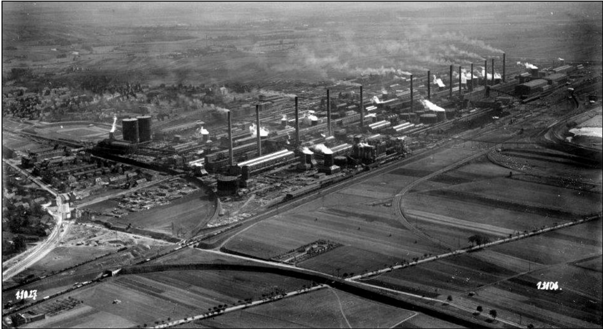
Bild 2 13 Kraftwerksschornsteine der Leuna-Werke (Luftaufnahme Fa. Junkers, 1.10.1927)
