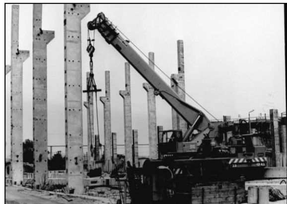
Bild 7 Baubeginn für die CTP-Anlage im Jahr 1981
