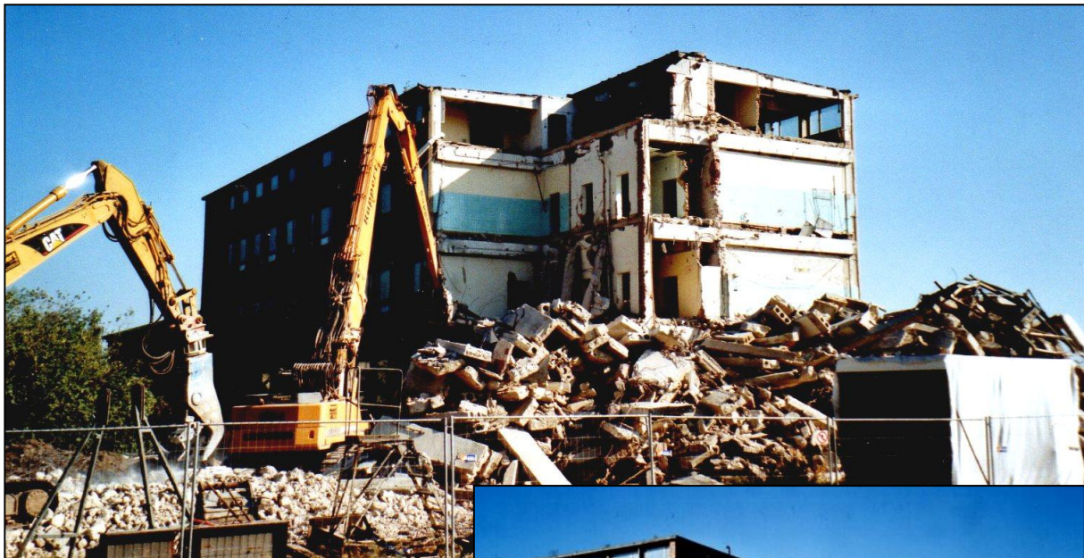
Bilder 5a+b_Abriss des Forschungsgebäudes Bau G 717 (Bild oben: Blick von Nordosten, Bild unten: Blick von Südwesten, vgl. Bild 1, 14.9.2006)
