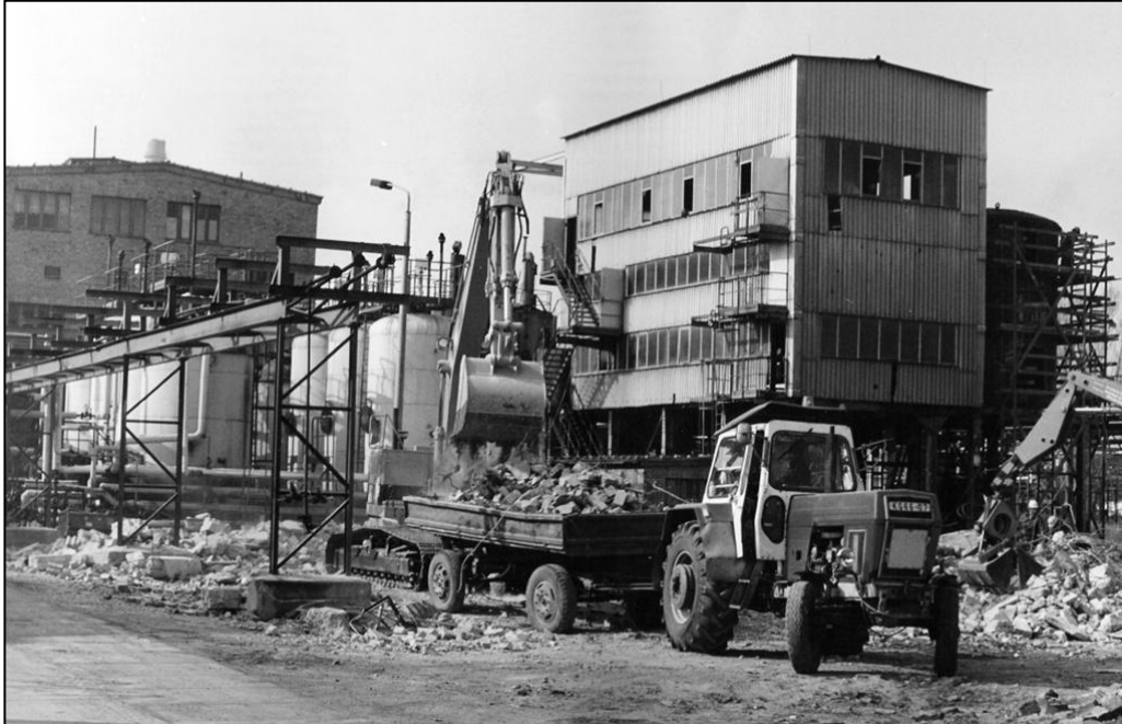
Bild 9 Additiv- anlage Bau K 304, Demontage der Anlage im Jahr 1993
