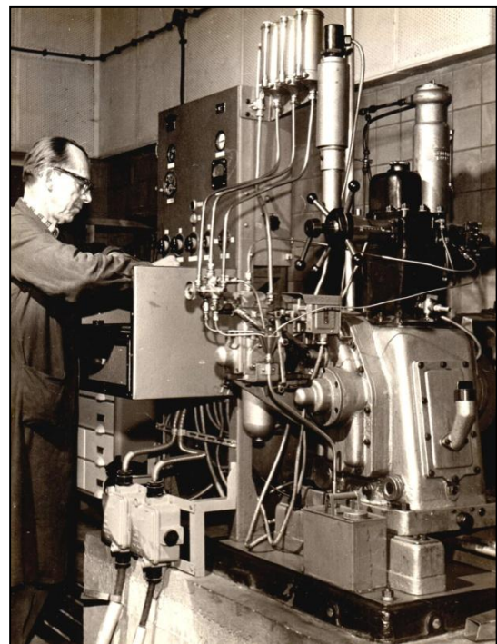
Bild 2 Prüfgerät für Dieselkraftstoff (1960/70er Jahre)
