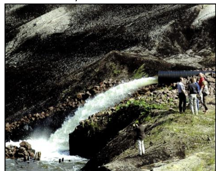
Bild 11 Am 28.4.2007 an der Einlaufstelle Frankleben erreichter Wasserstand (knapp anderthalb Jahre nach dort erfolgtem Einspeisungsbeginn, im Bild schön zu erkennen die nur 10%ige Neigung der abgeflachten Böschungen an der zukünftigen Seenkante bzw. dem Strandbereich)
