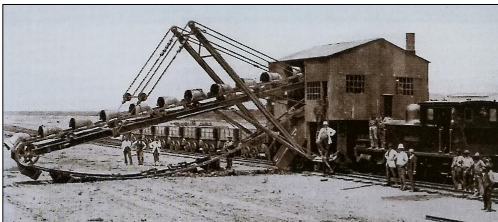
Bild 11 Erster Uihlein- Absetzer (erst- malig 1918/19 eingesetzt, hier um 1920) [6k]
