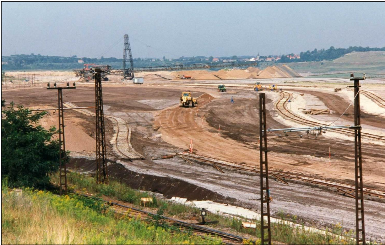
Bild 3 Schüttung der Stützkippe vor der Ortslage Biendorf mit dem Absetzer 966 (1996)
