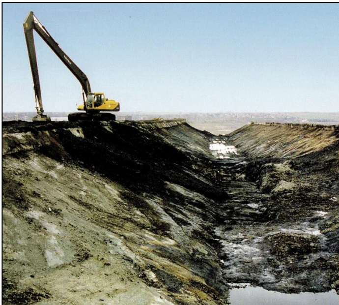
Bilder 5a+b Die sechs betonierten Säureharzbecken auf der Innenkippe ‚Leonhardt‘ während der Sanierung [7f,11b]
