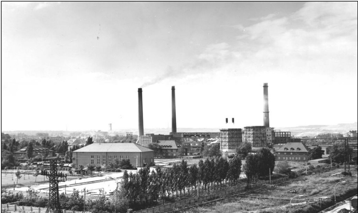
Bild 1 Das Mineralölwerk Lützkendorf 1955 (Blick aus südlicher Richtung auf das Kraftwerk West, im Vordergrund Schwimmbad und Kulturhaus, rechts die ‚Alte Verwaltung‘)
