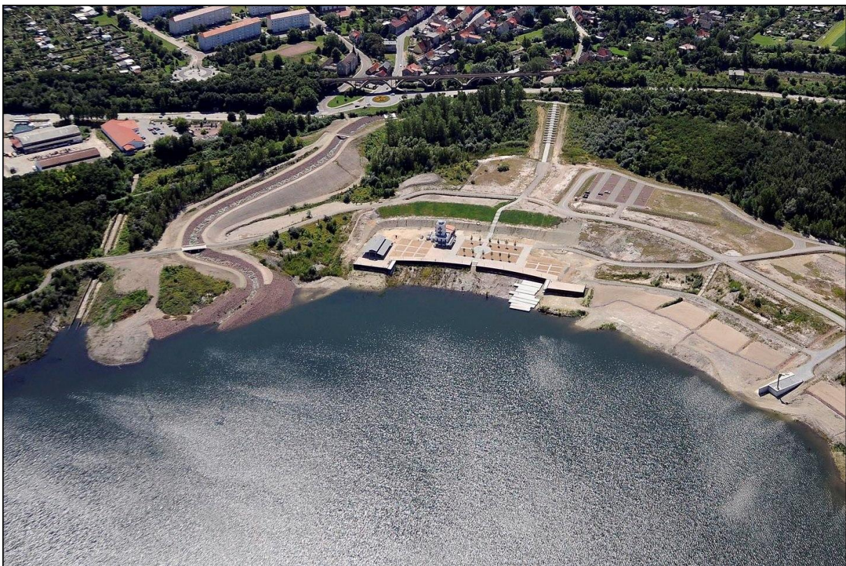
Bild 6 Alter (am linken Bildrand) und neuer Geiseleinlauf (mittig) an der im Bau befindlichen Marina Mücheln (2009)
