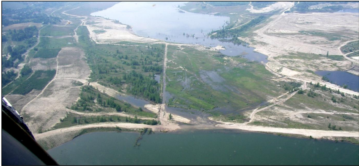
Bild 14 Der Tag des Überlaufens am 29.5.2008 (Luftbild v.30.5.2008, Blick von Osten, vgl. Bild 13)
