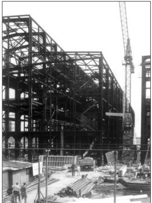
Bild 7 PVC-S-Fabrik im Aufbau
