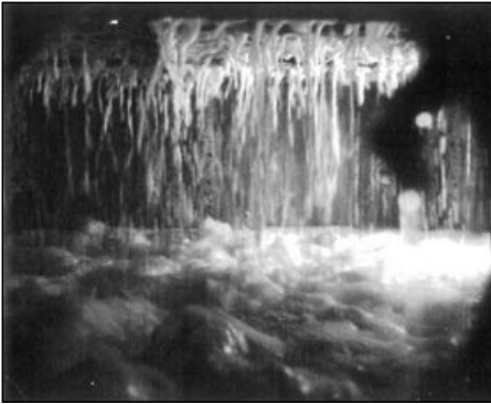
Bild 26 Blick zwischen die Böden der Kolonne (Durchregensysteme)
